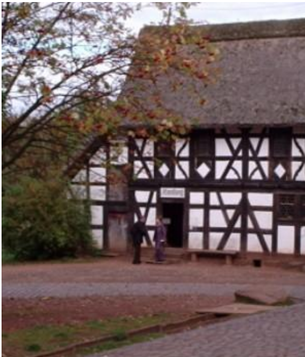
Fachwerkhaus im Freilichtmuseum Kommern
